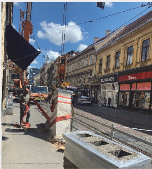
Slika 3. Fotografije uklanjanja oštećenih tavnanskih dimnjaka
