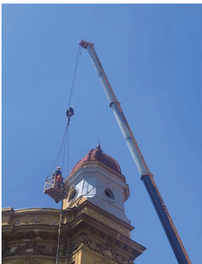
Slika 98. Nanošenje obloge i zatezanje kupole
