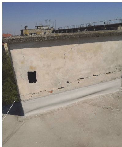
Slika 9. Blago do umjereno oštećeni dimnjaci
