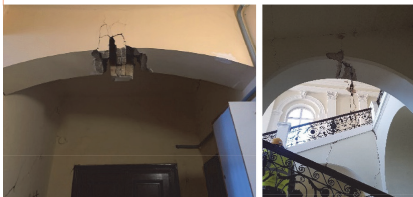
Slika 79. Fotografije oštećenih lukova
