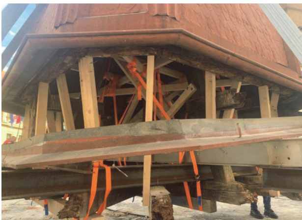
Slika 99. Fiksiranje kape kupole drvenom građom iznutra
