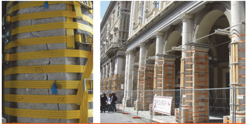
Slika 81. Fotografije ovijanja stupova, prema [12] (privremena sanacija)
