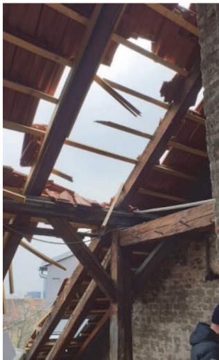
Slika 40. Fotografije oštećenih krovnih konstrukcija
