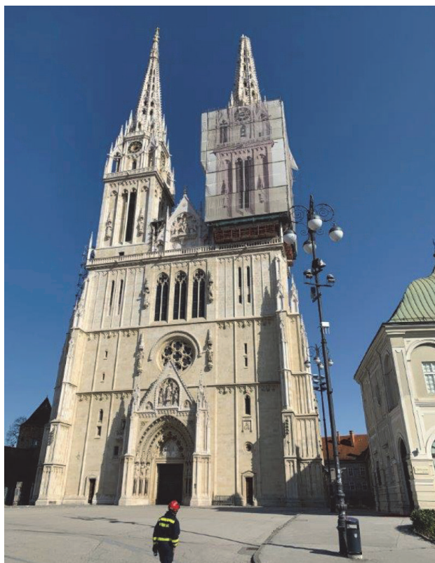
Slika 51. Kontrolirana demontaža dijela tornja kojemu je prijetila opasnost urušavanja
