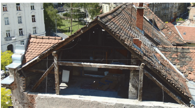
Slika 17. Fotografije oštećenih tavanskih zabatnih zidova
