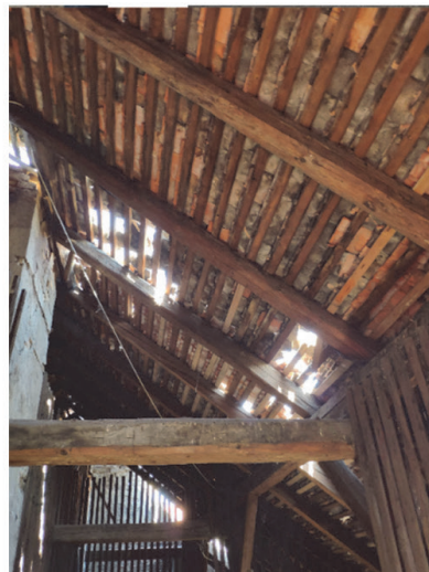
Slika 40. Fotografije oštećenih krovnih konstrukcija
