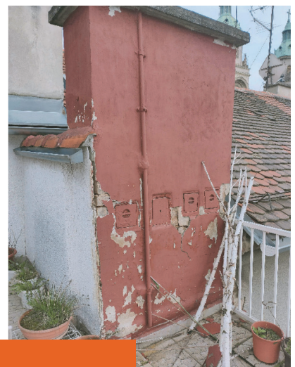
Slika 9. Blago do umjereno oštećeni dimnjaci
