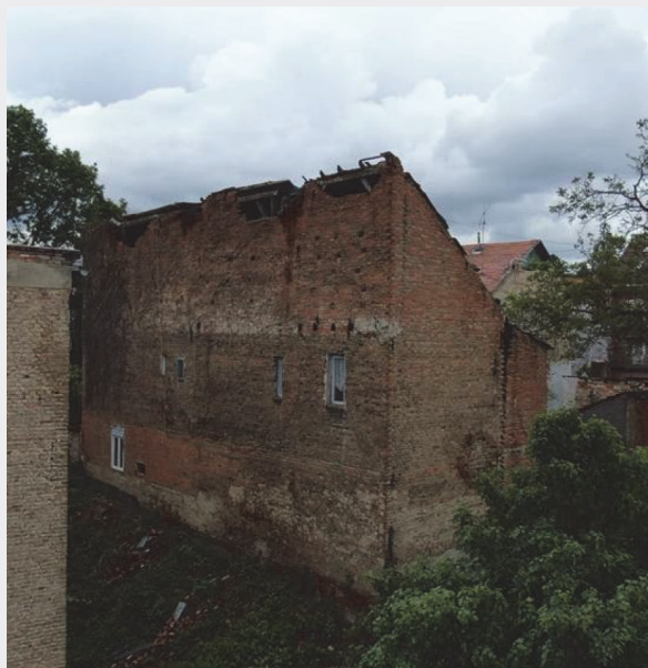
Slika 66. Primjeri potrebe za podupiranjem i sidrenjem
