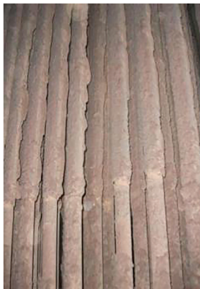
Slika 26. Lijepljenje pepela na izmjenjivačkim površinama
