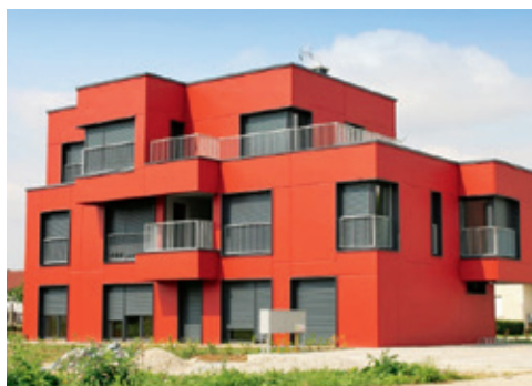
Slika 4. „PRVA ECO-SANDWICH® KUĆA“, Koprivnica
