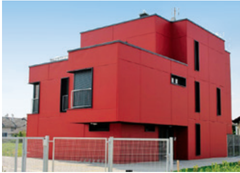
Slika 5. „PRVA ECO-SANDWICH® KUĆA“, Koprivnica
