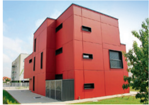
Slika 6. „PRVA ECO-SANDWICH® KUĆA“, Koprivnica
