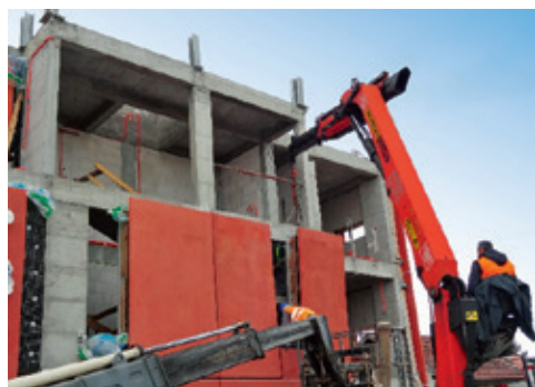
Slika 3. Gradnja „PRVE ECO-SANDWICH® KUĆE“ – prva primjena panela
