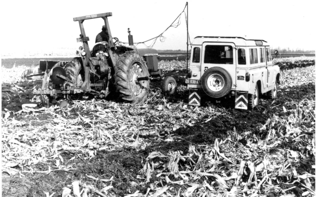
Slika 24. Mjerenje vučnog otpora oranja (1970-ih)
