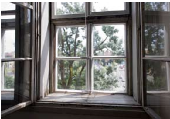
47. Detalj prozora s izvedenim produljenjem. Na donjoj strani izvorne sheme izvana je dodano krilo, a iznutra je izrađeno novo, cjelovito.
