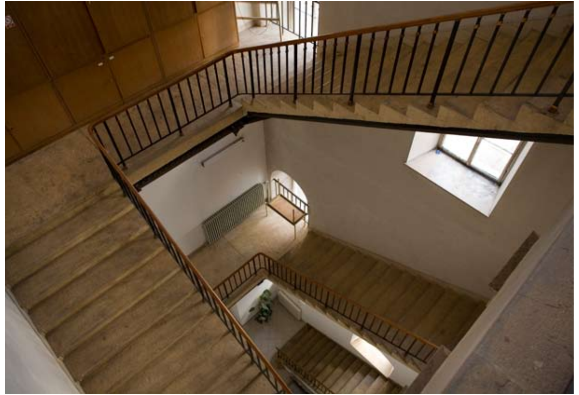
26 Pogled na podeste drugog i prvog kata
