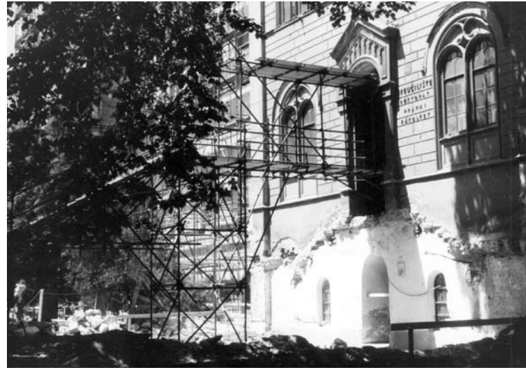
29. Postupno rušenje starog ulaznog stubišta s improviziranim drvenim stepenicama
