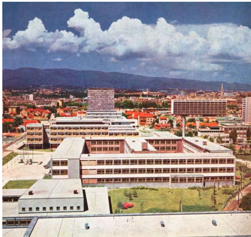
Novosagrađeni potez fakultetskih zgrada u Trnju
