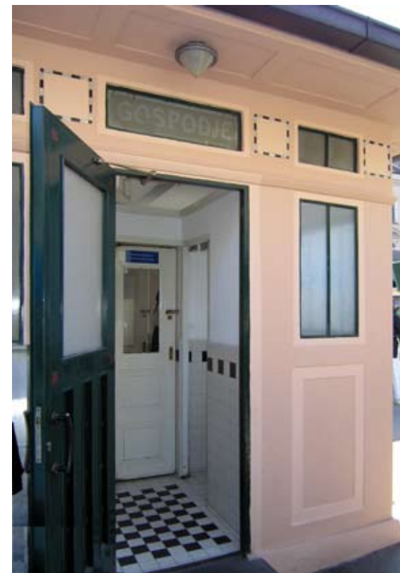
97. Javni zahod na Britanskom trgu nakon obnove 1994., detalj
