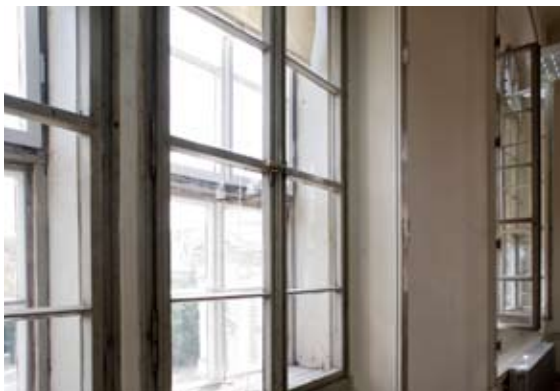
46. Detalj prozora sa sačuvanim okvirom doprozornika i okovom za kapke za zamračivanje kabineta fizike Foto.: Danilo Balaban
