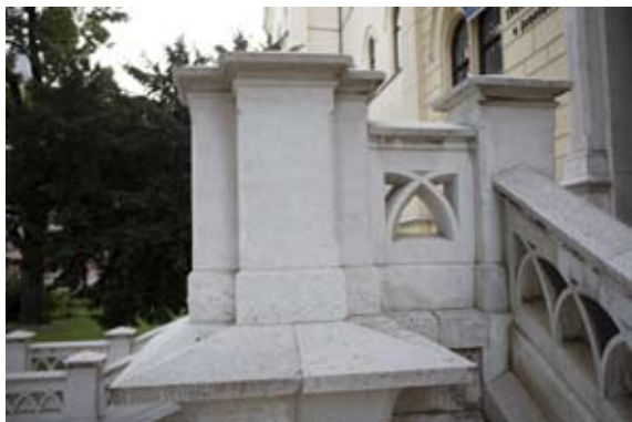
25. Produljenje ulaznog podesta za jedan modul ispune ograde
