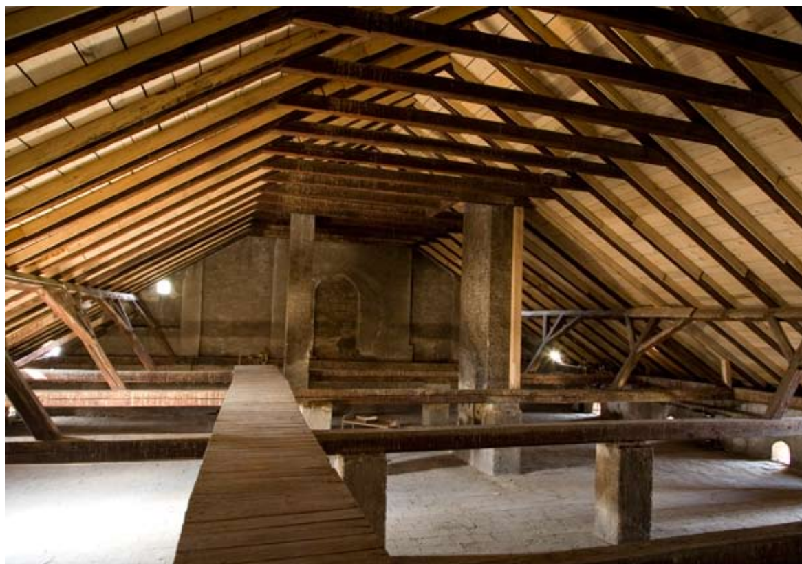
21. Krovište istočnog krila
