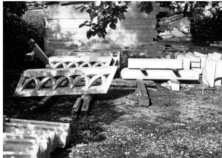
31. Izgradnja zapadnog kraka ulaznog stubišta
