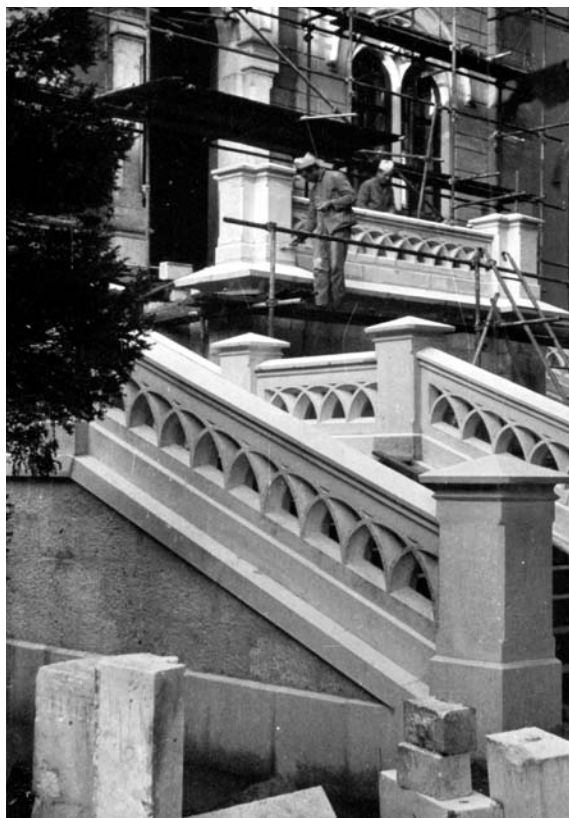
33. Dovršetak obnove kamenog stubišta
