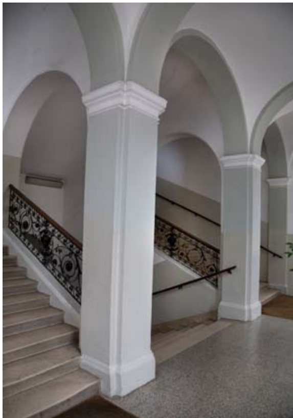
58. Međupodest stubišta Foto: Danilo Balaban
