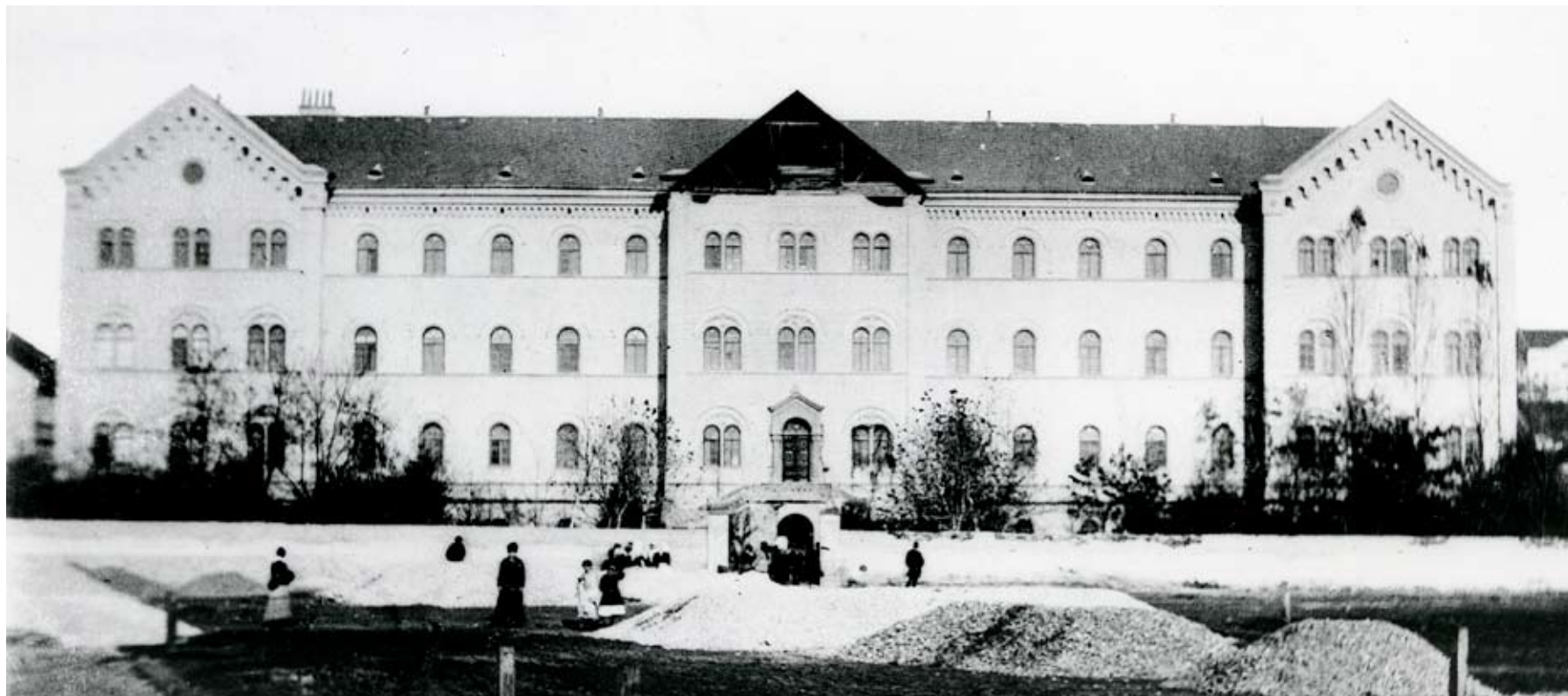
40. Zgrada tvornice svitakah, 1882. s oštećenjima od potresa 1880. Foto: Hermann Fickert
