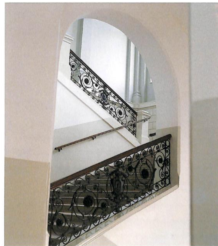
Stubište, foto Miroslav Dvorščak, prof., 1997.
