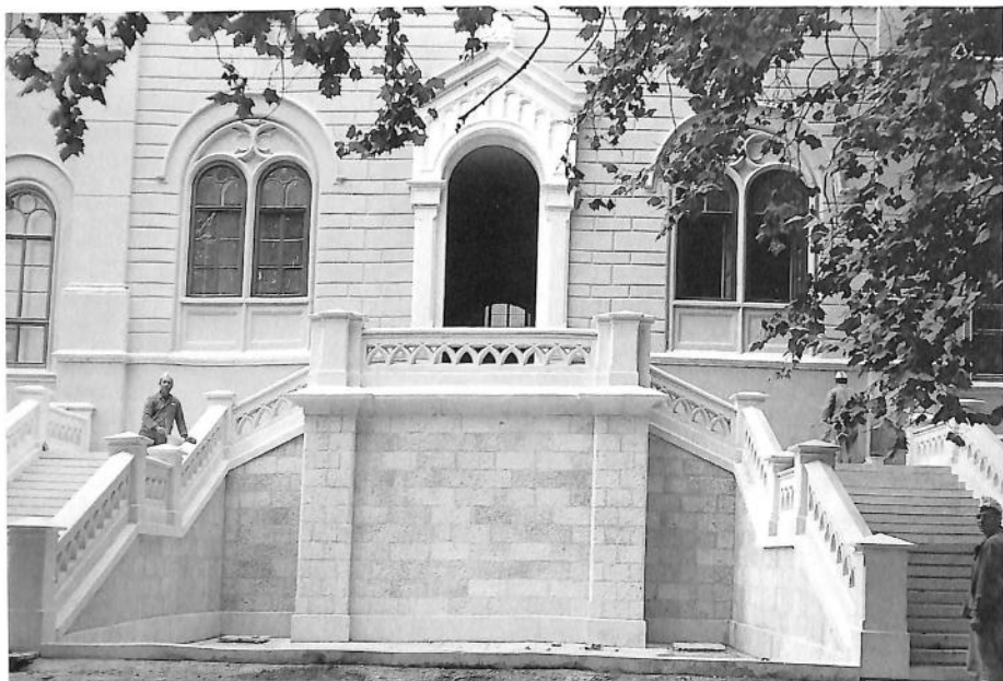
Radovi na obnovi ulaznog stubišta, 1969., foto Josip Vranić
